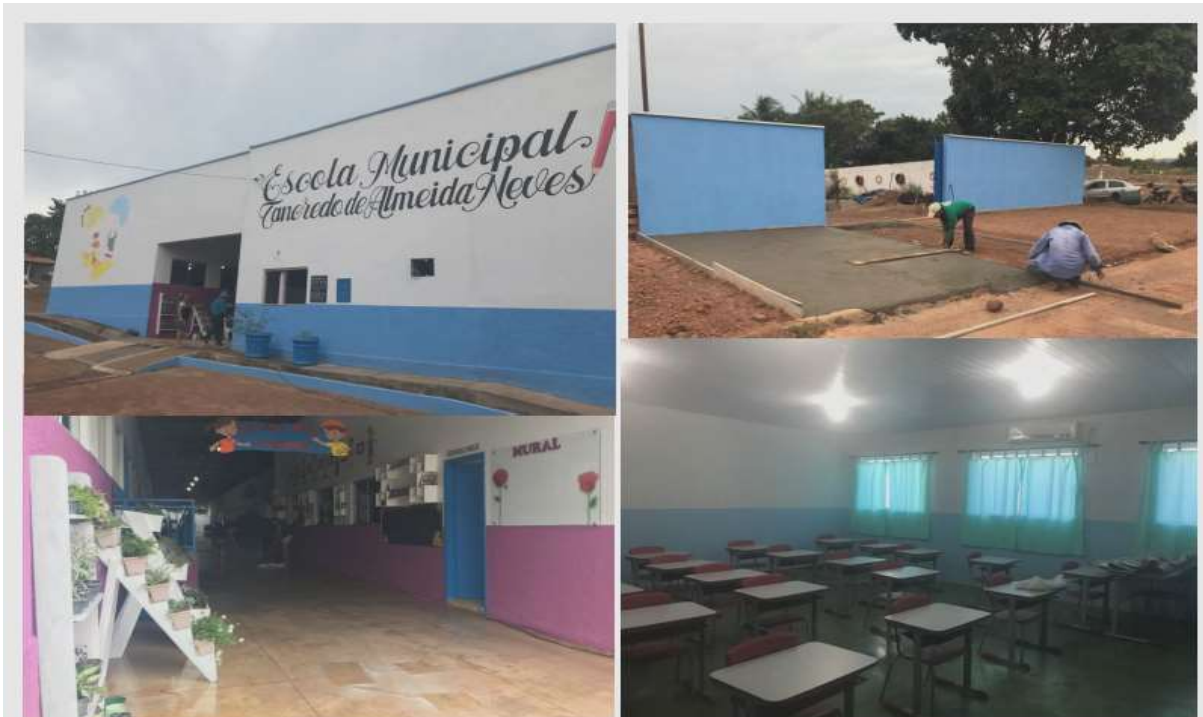
Pintura da escola Tancredo, construção da entrada principal da escola e ampliação do quadro elétrico da escola.
