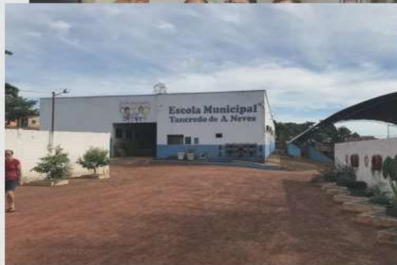
Escola antes da pintura
